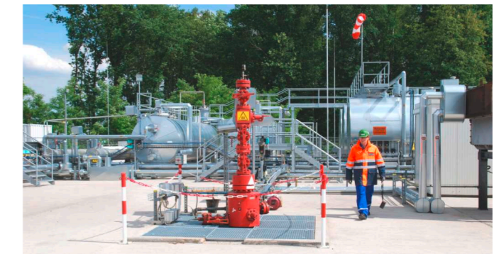
Beispiel: Eruptionskreuz auf der Bohrung Römerberg 1
